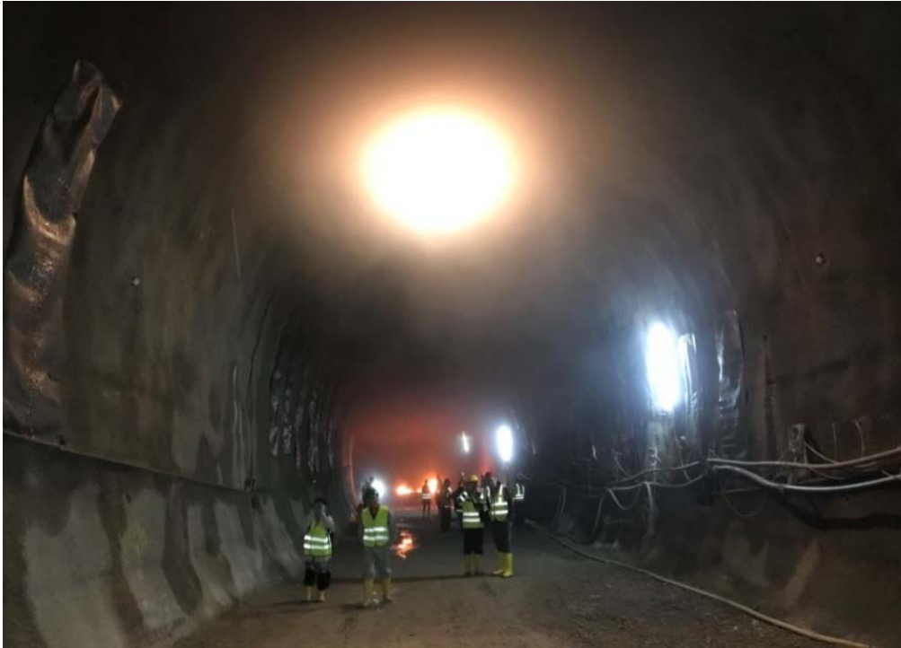
図 10 レオベン鉱山大学 実大トンネル実験施設（単線鉄道トンネル断面）
